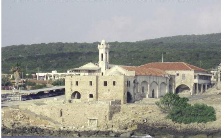
Das berühmte Andreaskloster am Nordostende von Zypern. Unter dem Turm in der Mauer ist die Quelle des Andreas.
